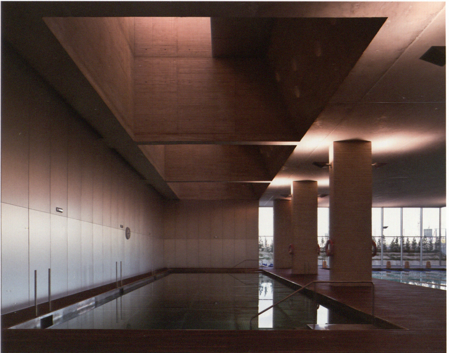
La planta baja (piscinas) y la segunda (gimnasio) liberadas por el uso de grandes vigas en la planta intermedia. The ground floor (swimming pools) and the second floor (gym) freed by the use of great beams in the middle floor.
